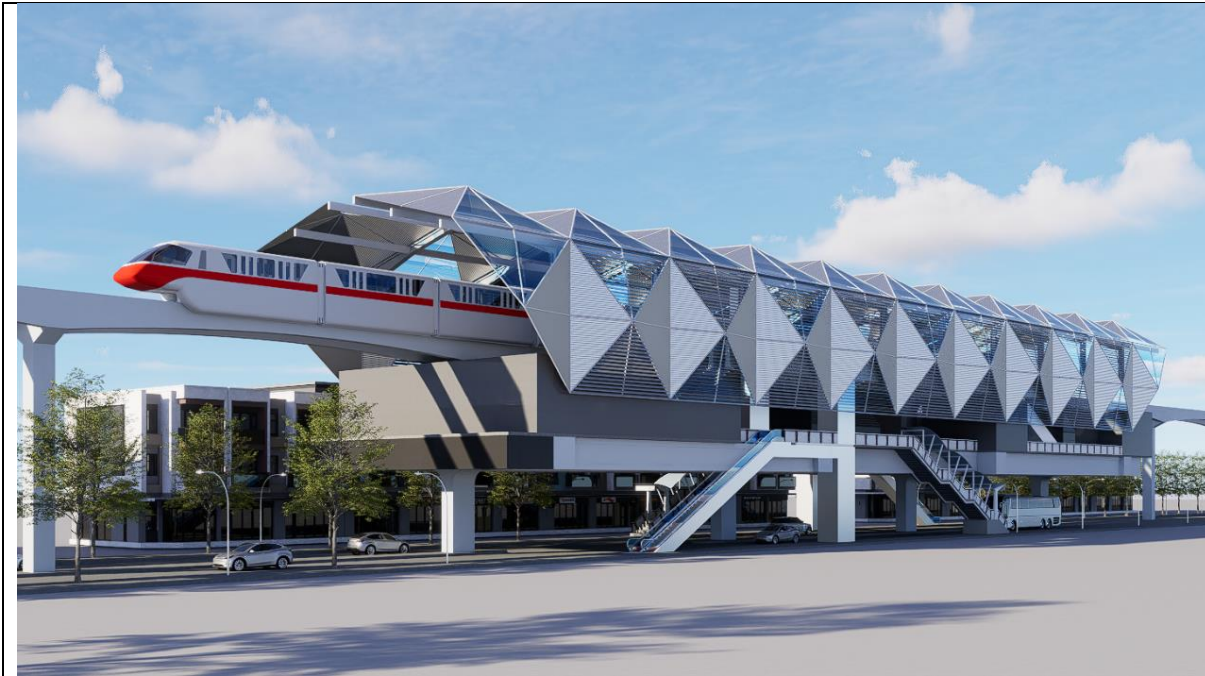
รูปที่ 5-7 สถานีแบบชานชาลาอยู่ตรงกลางตรงกลางใช้กับพื้นที่ที่มีเขตทาง 20 เมตร ขึ้นไป
